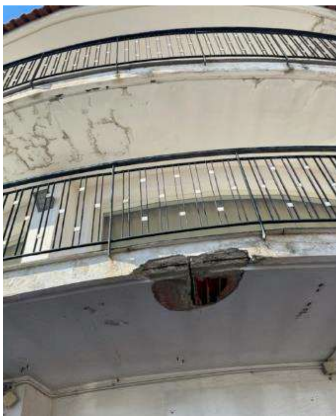
FOTO 36 – AMMALORAMENTO AGGETTO
