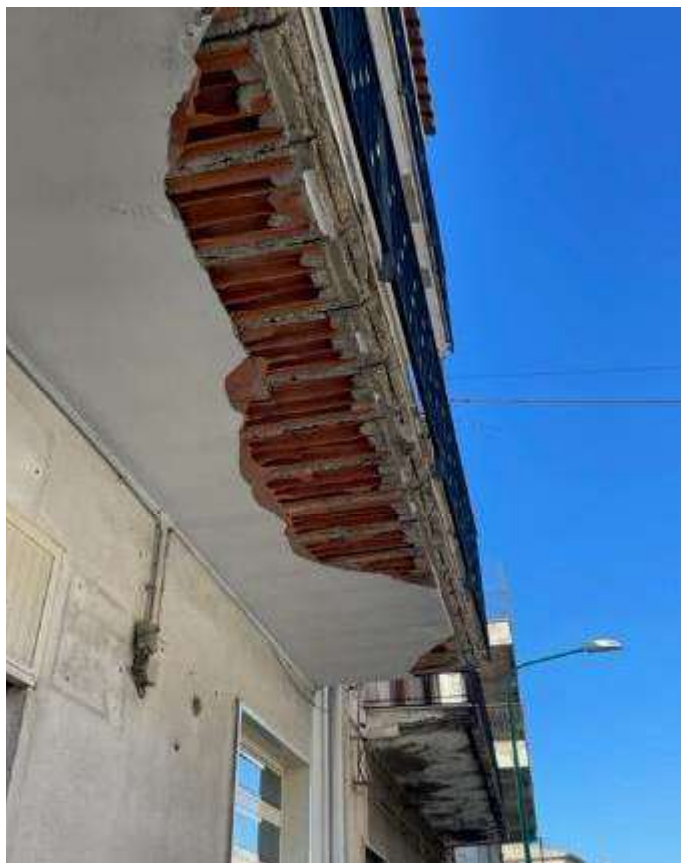
FOTO 35 – AMMALORAMENTO AGGETTO
