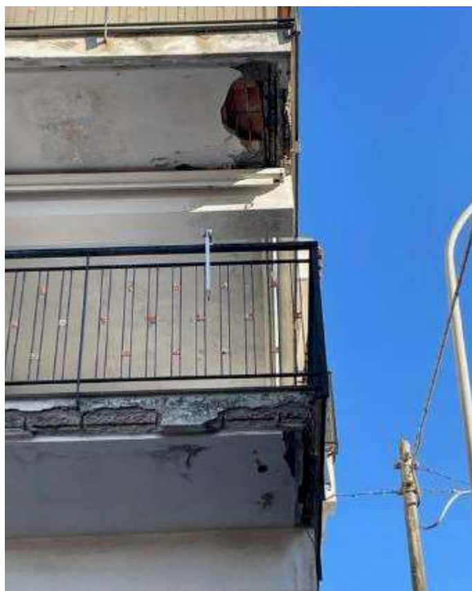
FOTO 34 – AMMALORAMENTO AGGETTO
